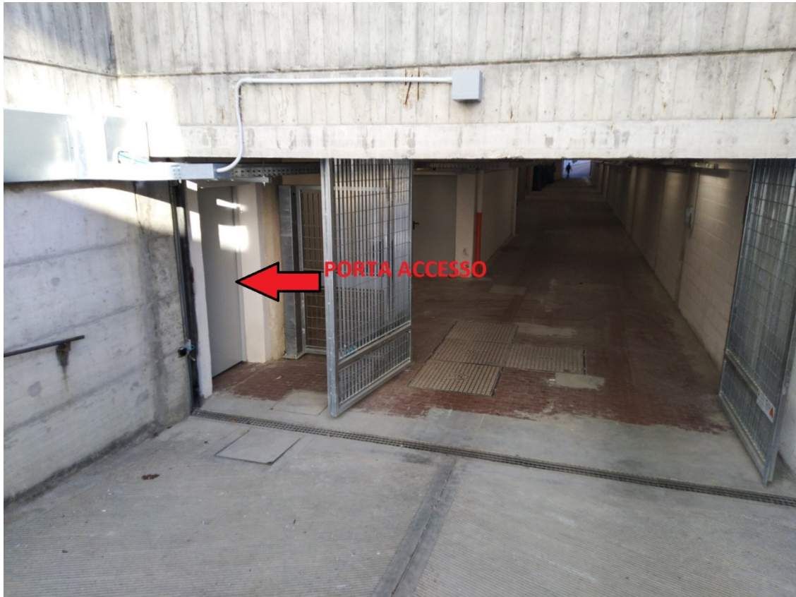
RAMPA ACCESSO INTERRATO
